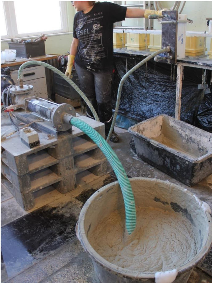
Abbildung 14: Injektion des gepumpten Schaummörtels
