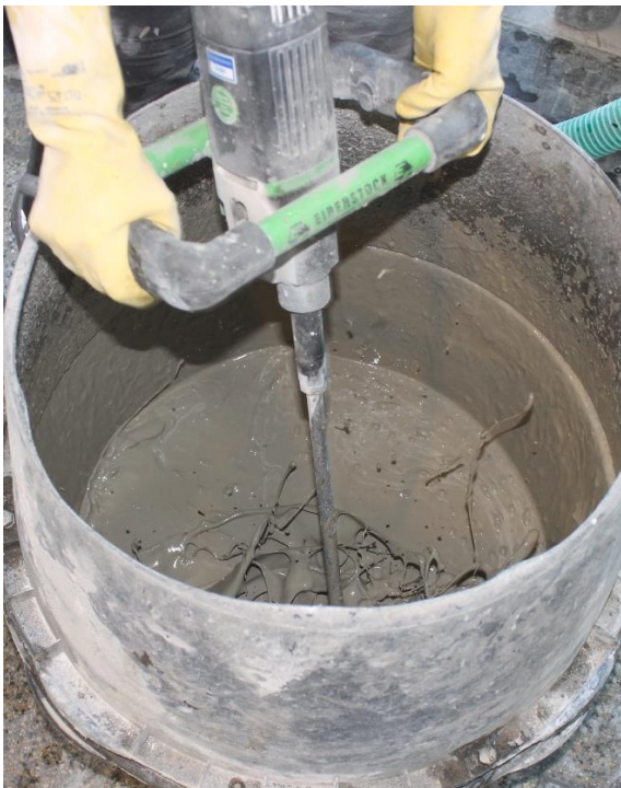
Abbildung 23: Mischen des Bindemittelleims
