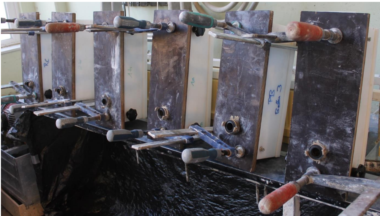
Abbildung 22: Verschlossene Schalungen vor der Schaummörtelinjektion
